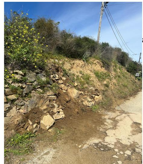
*Exemple d'un mur en pierres sèches effondré au cours de fortes intempéries*
