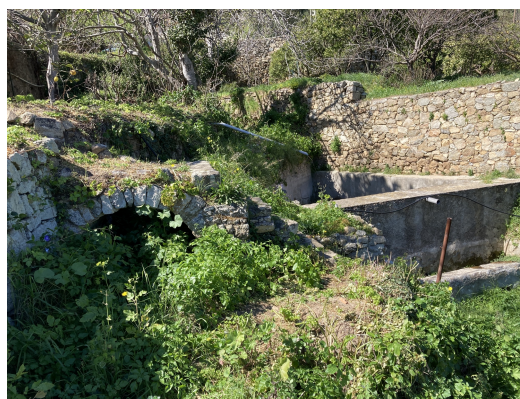
Bassin de récupération, adossé au lit du ruisseau, exutoire de la fontaine et des eaux de ruissellement de Palmentu, sous le bassin le lavoir de la propriété.
