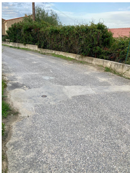
Exemple de remise en état de la voirie après intervention sur réseau souterrain
