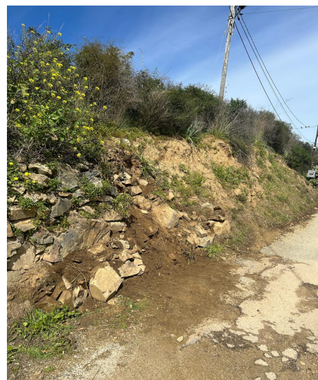
Exemple d'un mur en pierres sèches effondré au cours de fortes intempéries
