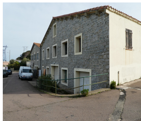
La fromagerie Roquefort, route de Santa-Reparata-di-Balagna
