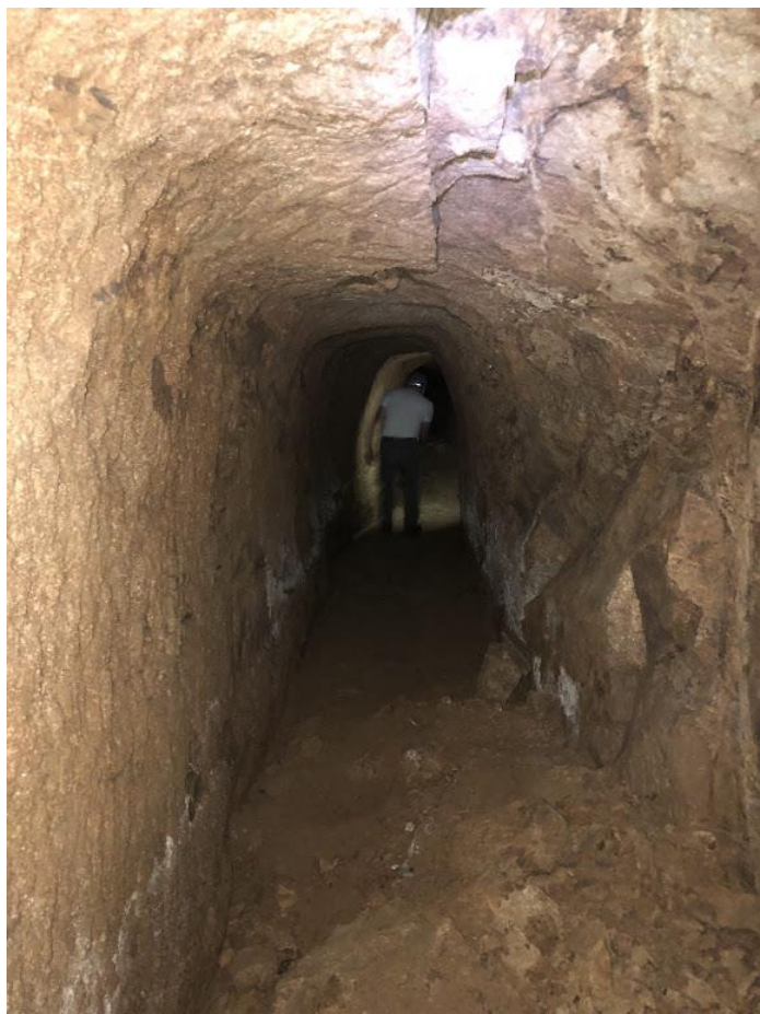
La dimension de la galerie permet à un homme de se tenir debout, même si elle va en se rétrécissant. Elle parcourt une quarantaine de mètres. Le sol est plat avec une rigole située à droite quand on s'engouffre dans la galerie. Photo © S. Garrone
