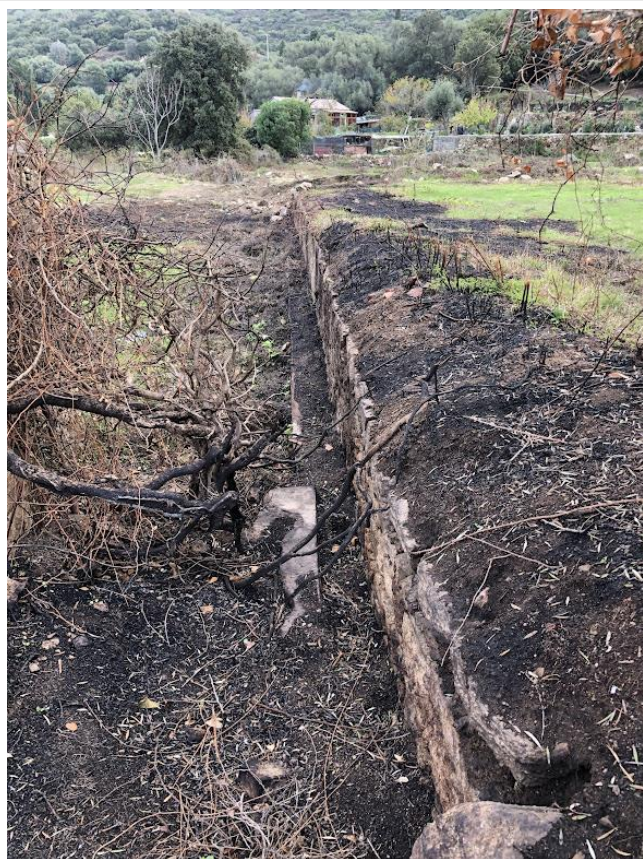
Rigole d'irrigation au pied d'une murette.
