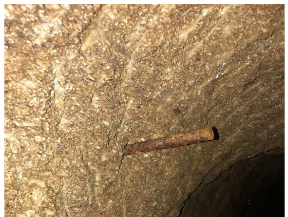
Détail de la paroi avec les traces des pics qui ont creusés la roche ainsi que pieux en métal plantés pour pouvoir soutenir les lanternes. Photo © S. Garrone
