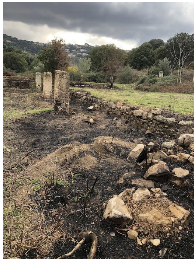
Piles a verde soutenant l'ancienne pergola qui venait ombrager la rigole qui court au pied de la murette de soutènement. Photo © S. Garrone.
