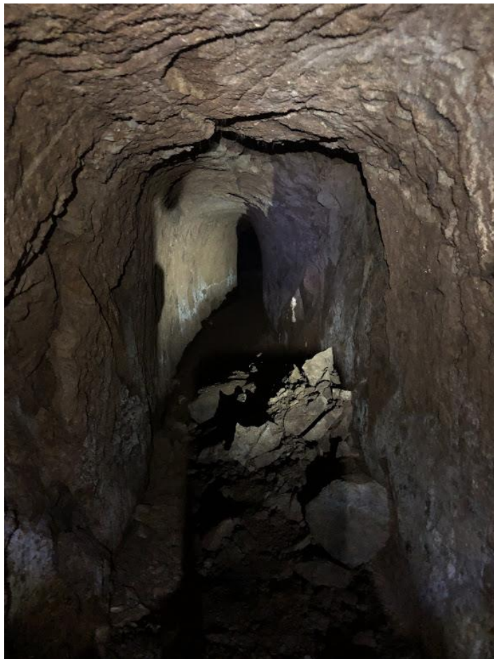
Galerie montrant des effondrements sur les parcours de l'eau. Photo © S. Garrone
